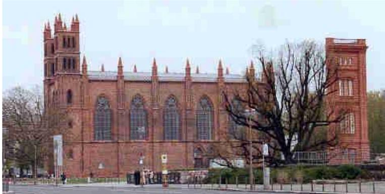
einschiffiger Saal mit Wandpfeilern und eingezogenem Chor an mit zwischen die einwärts vor tretenden Strebepfeiler eingespannten Emporen. In der Ausführung des Backsteinmauerwerks und den Details orientiert sich Schinkel an der Backsteingotik im Norden Preußens.<sup>46</sup> Bei der Einfachheit des Gebäudes kam es auf besonders sorgfältig und für jeden Bauteil zweckmäßig behandeltes Backsteinmaterial an, das sichtbar belassen wurde.
